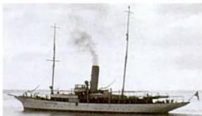
Le yacht Elettra de Marconi avec ses deux mâts supportant l'antenne.
