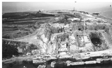
Les impressionnants travaux de terrassement laissent apparaître l'emplacement des deux grands bassins de 120 m de long creusés dans la roche. © Stéphane Jézéquel
